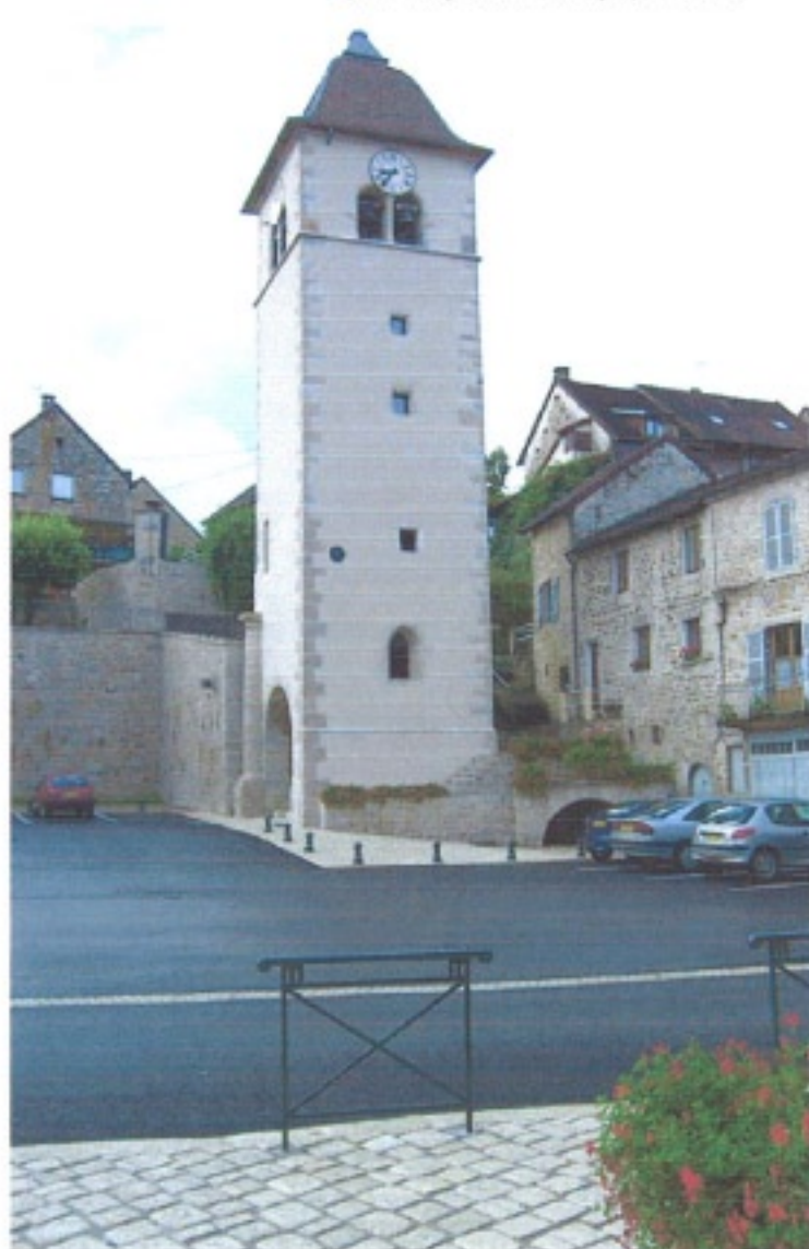
Etat après réhabilitation
