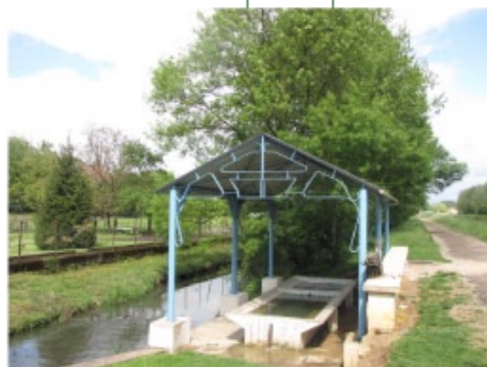
Lavoire ancien restaurée et stylisé le long de la voie verte
