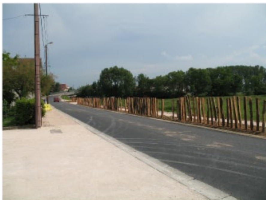
Le cheminement rural, nouveau lien entre centre et canal
