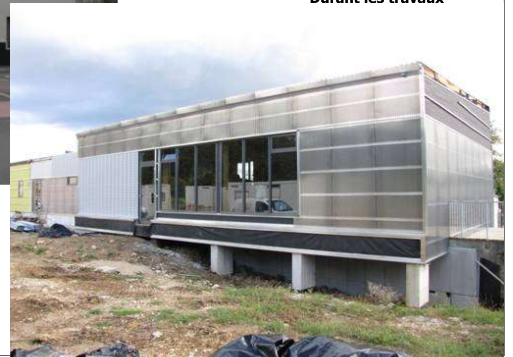
Durant les travaux
