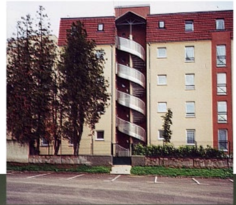
La façade sur l'avenue, les cheminements et les jardins privés, les cages d'escalier avec ascenseur
