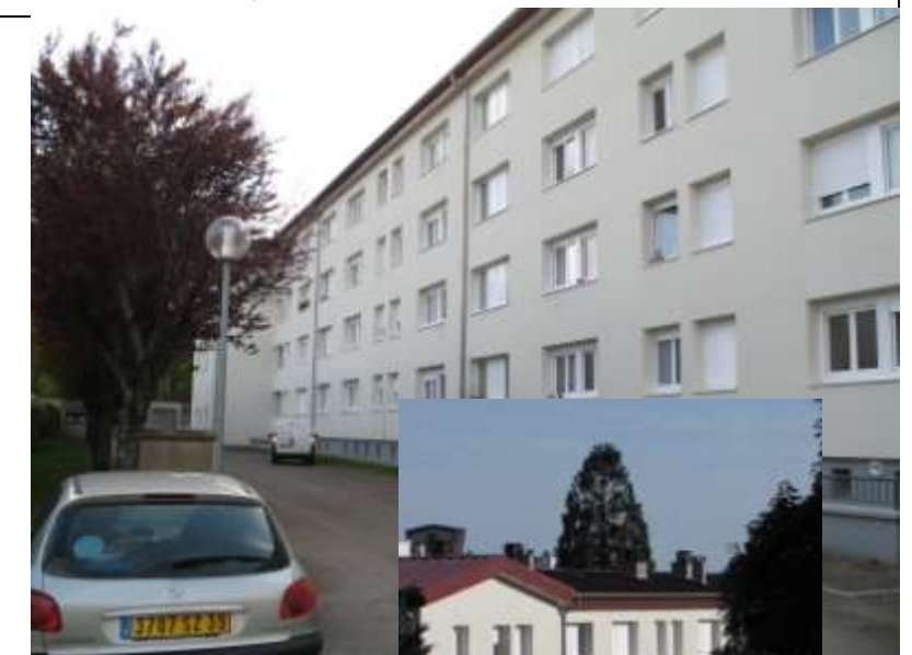
Vues du quartier après travaux
